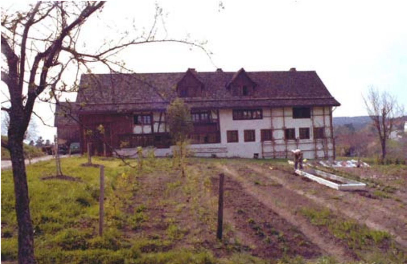
Ostfassade: Gebäudezustand nach der Sanierung 1978
