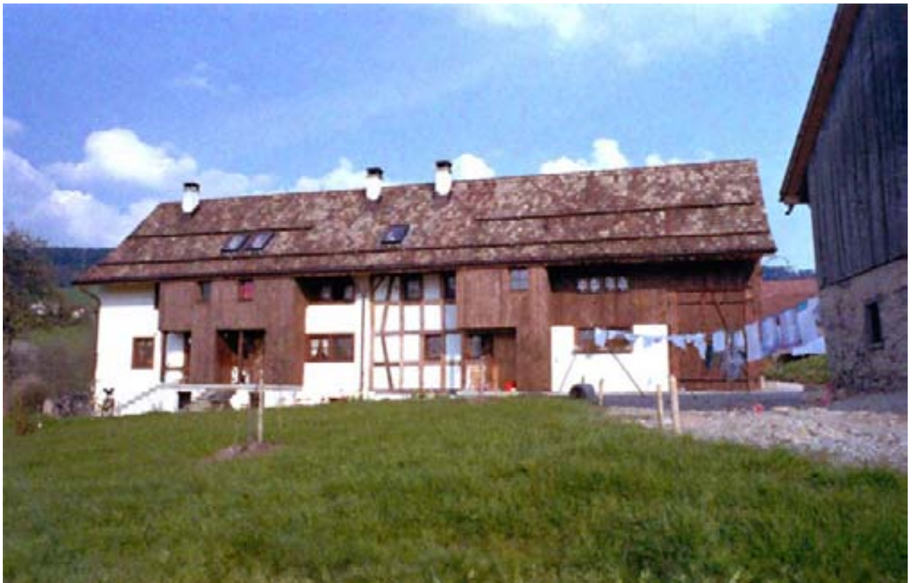
Westfassade: Gebäudezustand nach der Sanierung 1978
