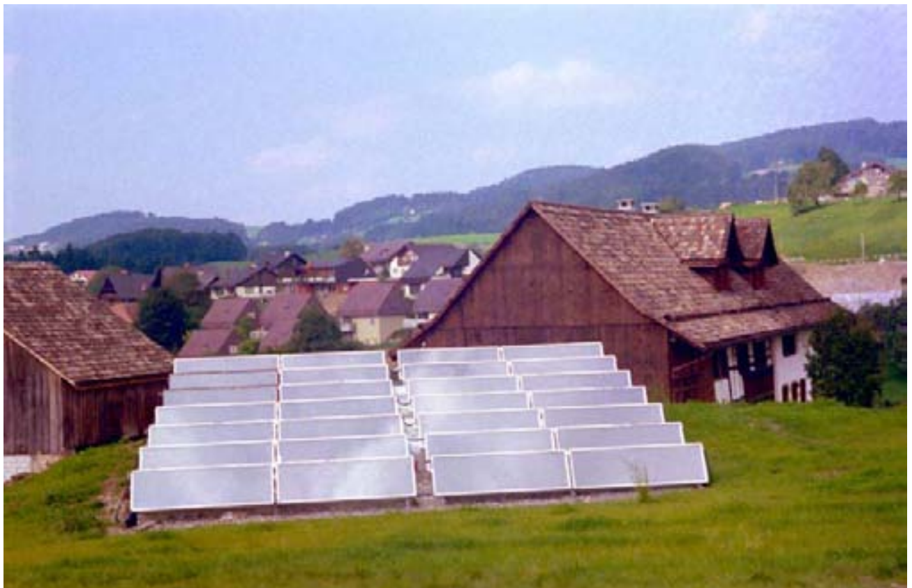
Solarkollektor-Anlage mit saniertem Gebäude im Hintergrund 1978 Max. Ertrag: 45° Neigung in Richtung Süd, 500 kWh/m 2 a (nach EIR)
